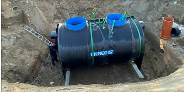
Lamellenklärer ENREGIS/Vivo Pipe® LC: einbaufertig und termingerecht zur Baustelle geliefert und innerhalb von nur 30 Minuten aufgestellt und angeschlossen
