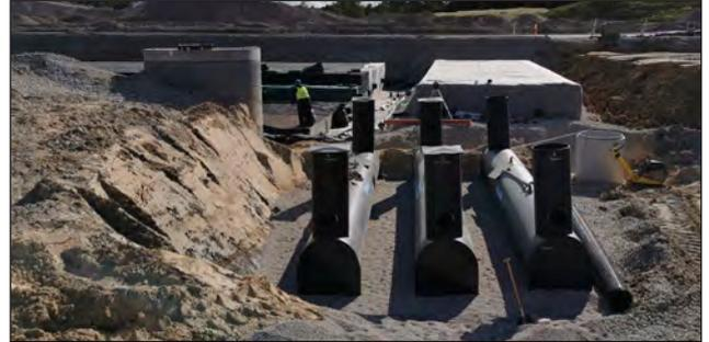
Kombination ideal aufeinander abgestimmter Komponenten der ENREGIS® Systemtechnik: ENREGIS/Vivo Pipe® Sedimentations-systeme, Behandlungsanlage sowie Retentionsystem
