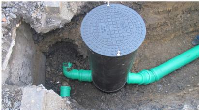
Anschluss Weiterführung zum Versickerungsmodul
