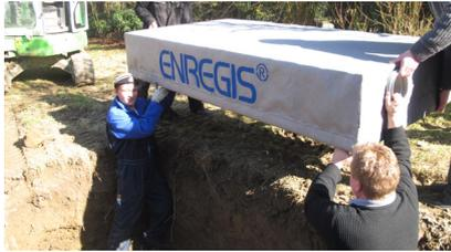
Einsetzen der Versickerungsmodule
