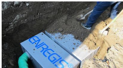
Anfüllen der Module mit Boden
