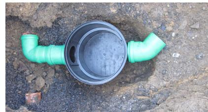
Kanalisationsentkoppelung, Filterschacht Anschluss
