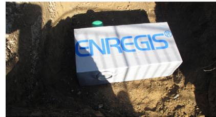
Positionierung der Versickerungsmodule in der Grube
