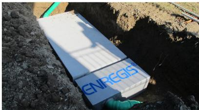
Versickerungsmodule mit fertiger Verrohrung
