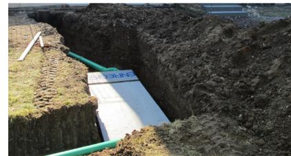
Filterschacht, Module u. Verrohrung zum Entlüftungsschacht
