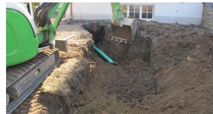
Abschluss der Verfüllung, unterhalb Fahrflächen-Verdichtung
