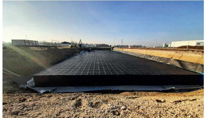
Zusammengesetzte X-Box® VC Elementen bilden einem homogenen Rigolenbaukörper in Wien (Österreich)
