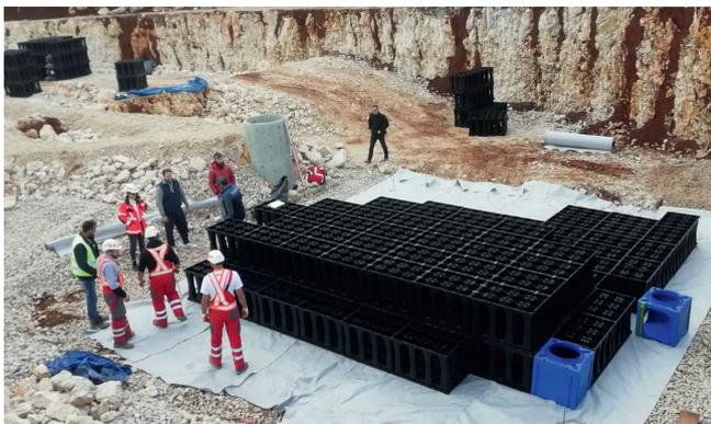
Aufbau eines Rigolenkörpers aus logistikoptimierten ENREGIS Komponenten in Zadar (Kroatien)
